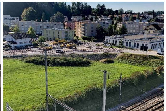
Blick auf die Kreiselsbaustelle und die Migros Parzelle (J. Matter)
